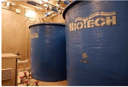
ถังน้ำสำรองสำหรับใช้รดน้ำต้นไม้ รูปที่ 7 ระบบน้ำใช้ (ต่อ)
